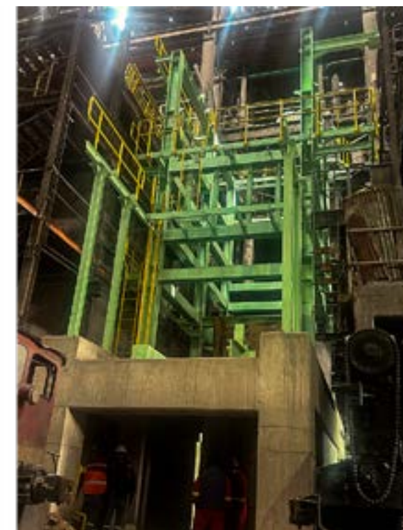
Ejecución de obras civiles Volatilizador V
