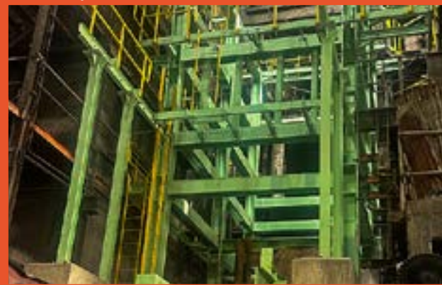
Construcción y Rehabilitación del Horno Volatilizador V
