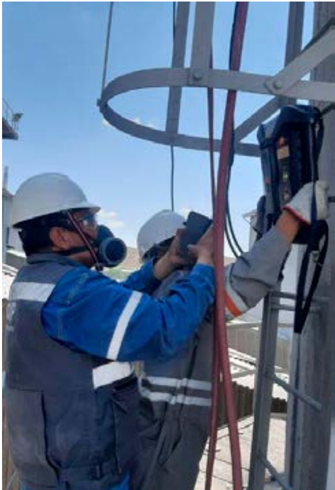
Monitoreo de emisión de gases chimenea
