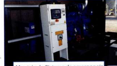
Montaje de Sistema de emergencia
