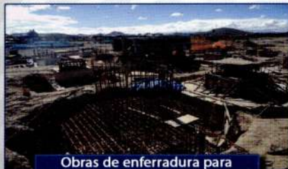
Obras de enmallado para cabezales del edificio
