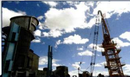
Montaje de columnas principales alrededor del Horno
