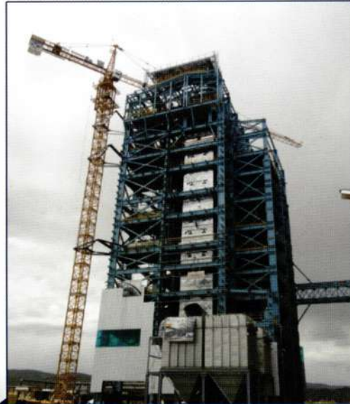
Montaje del edificio del Horno concluido e inicio de cerramiento
