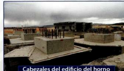
Cabezales del edificio del horno concluidos y montaje de grilla
