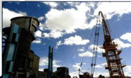
Montaje de columnas principales alrededor del Horno
