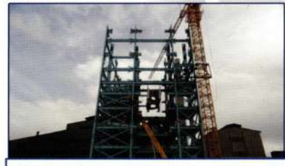
Montaje de transición de Horno Ausmelt
