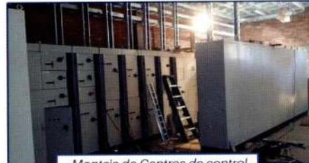
Montaje de Centros de control de motores
