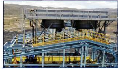
Montaje de condensador y puente grúa
