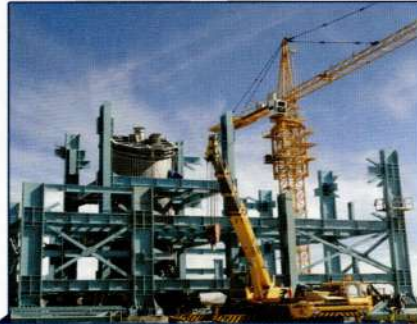
Montaje de vigas y perfiles - Nivel 7500
