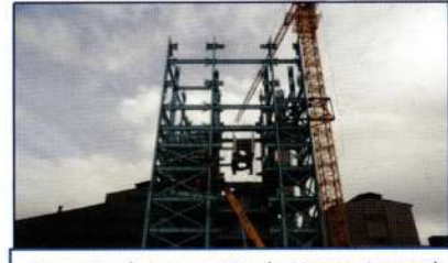
Montaje de transición de Horno Ausmelt
