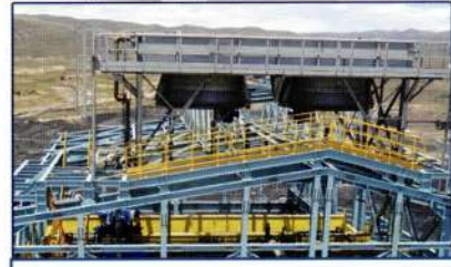
Montaje de condensador y puente grua
