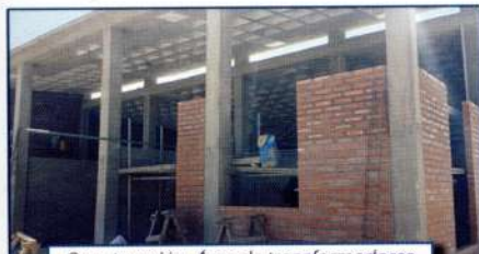
Construcción Área de transformadores y Sala eléctrica
