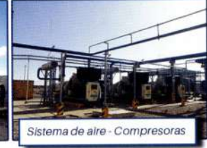
Montaje del sistema de aire
