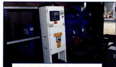
Montaje de Sistema de emergencia
