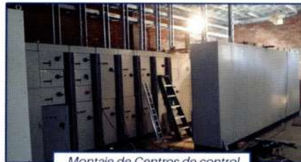
Montaje de Centros de control de motores
