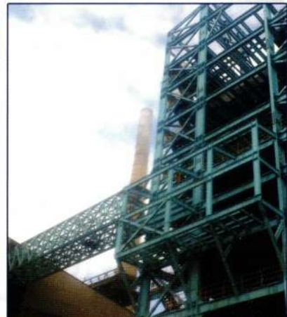
Montaje del Puente de Interconexión entre la Nave 3000 y el edificio Ausmelt
