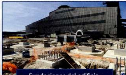
Fundaciones del edificio
