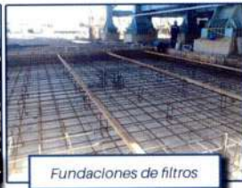
Obras Civiles - Torres y Compresoras
