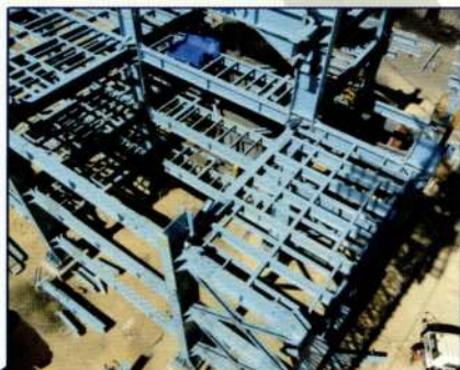
Montaje del edificio del Horno— Nivel 20800
