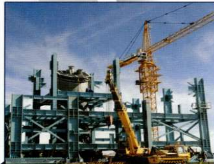
Montaje de vigas y perfiles - Nivel 7500
